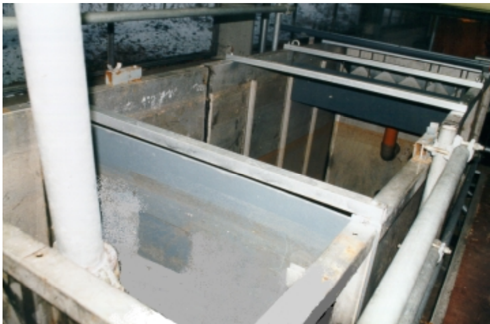
Blick auf das Versuchsbecken von oben
