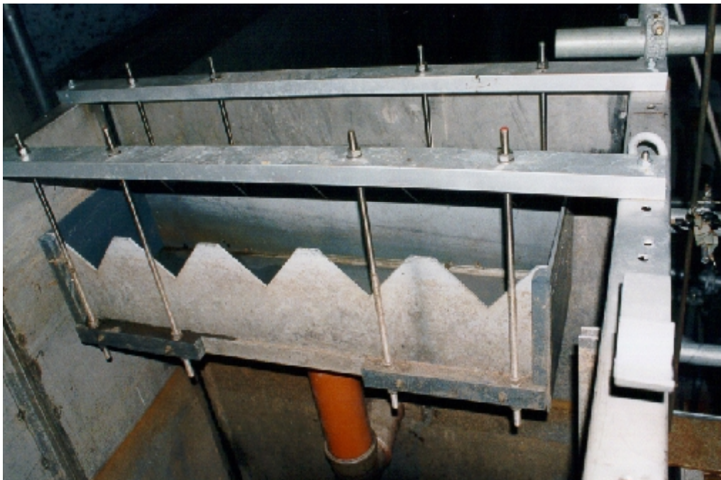
Ablaufrinne (Klärüberlauf) am Ende des Beckens
